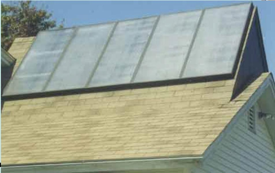
La cubierta del edificio permite a los captadores solares tener mejor orientación e inclinación
